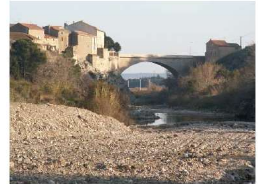
Franchissement de la Berre par le Pont de Tamaroque RD3 (Vue vers l'aval)
