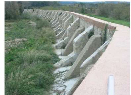
- Digue de l'Espinat sur l'ancien lit de la Berre
