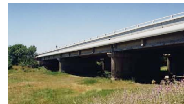
Ouvrage de décharge pour les crues de l'Orb à Béziers (photo Scetauroute)
