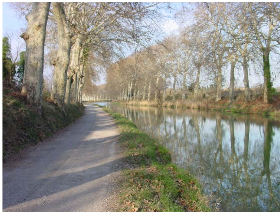
Le canal du Midi, au sud de Colombiers (photo Scetauroute)
