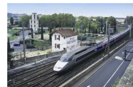
Voie ferrée Montpellier / Cerbère à Béziers (photo Scetauroute)
