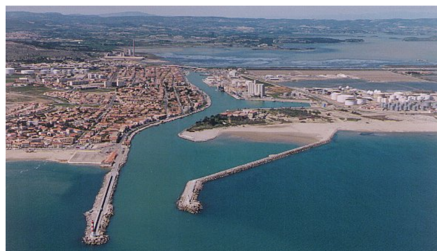
Site industriel de Port-la-Nouvelle (source DDRM de l'Aude - site internet)
