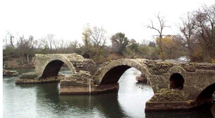
Pont romain sur l'Hérault (photo Scetauroute)
