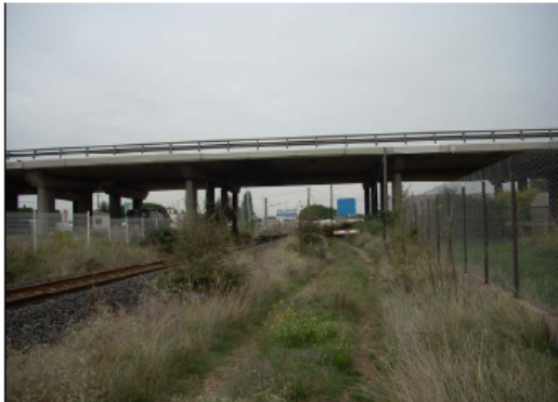
AUTOROUTE A9 Km 5+256 + PN 1 Km 5+335 création pont route largeur 24m en place du PN1
