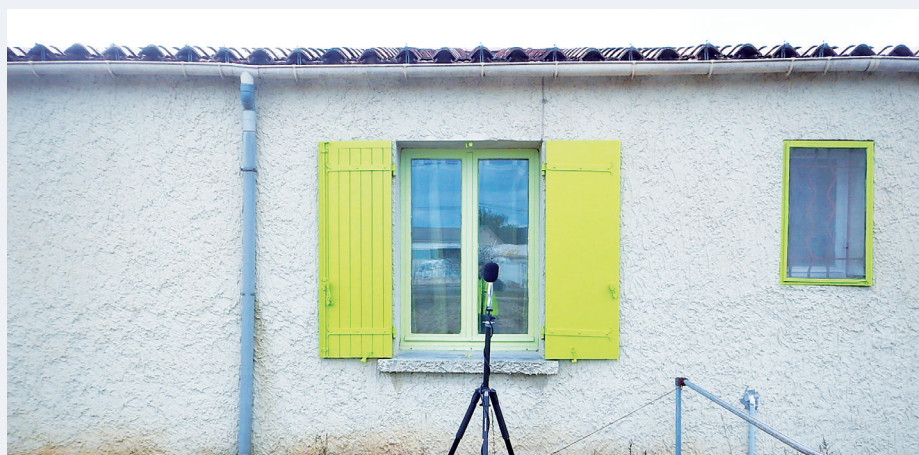
Prise de mesures acoustiques sur site
