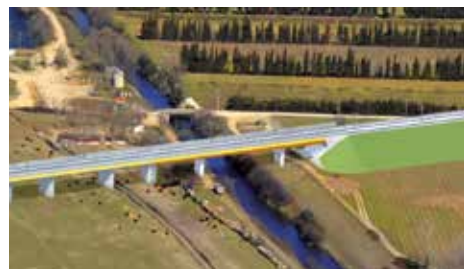
Viaduc du Vistre sur CNM (Contournement ferroviaire Nîmes-Montpellier)
