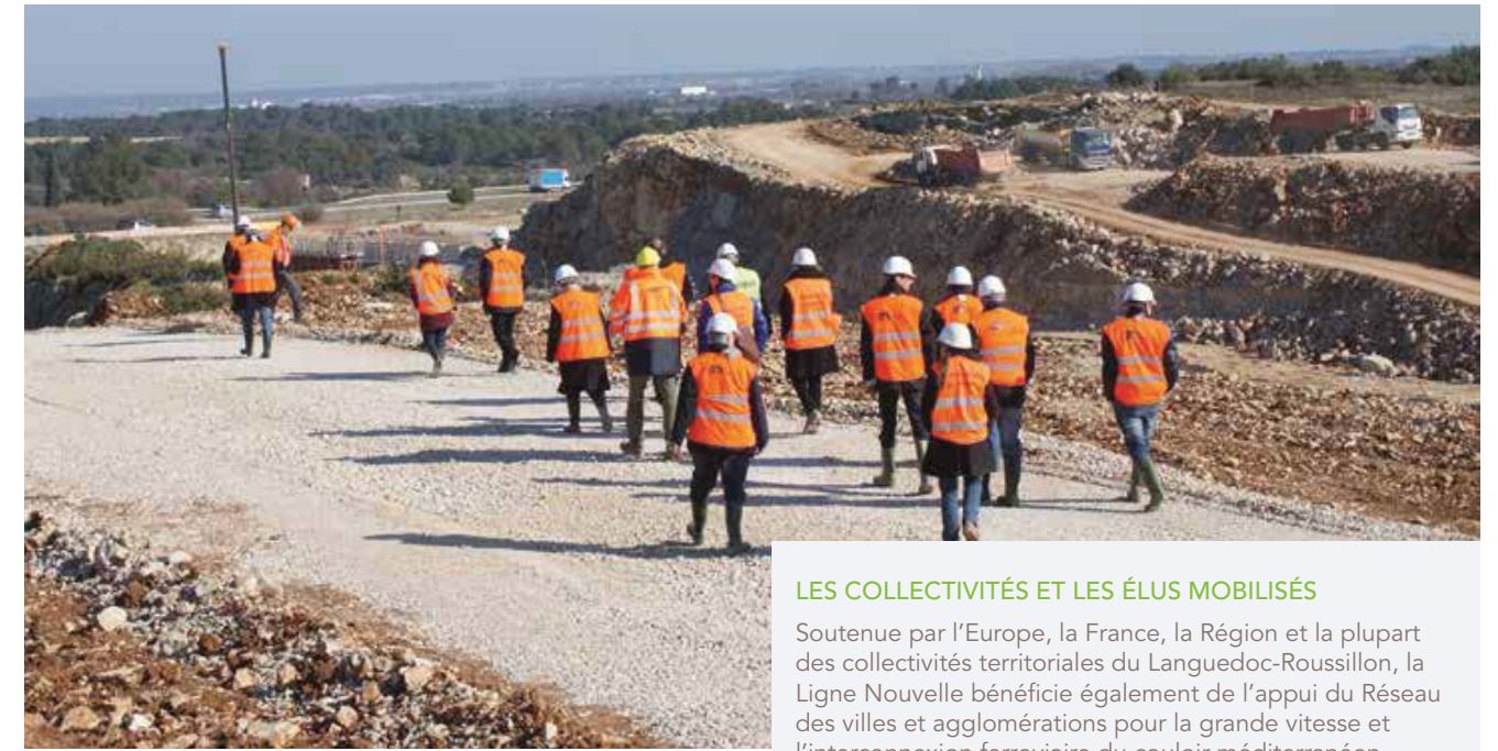
Visite du chantier CNM le 18 février 2015 à Nîmes
