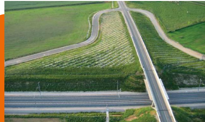
Adoucissement des talus - LGV Rhin-Rhône
