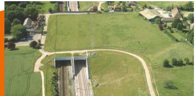
Tranchée couverte sur HS1
