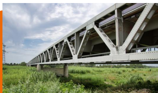
Ouvrage de décharge - Cavaillon
