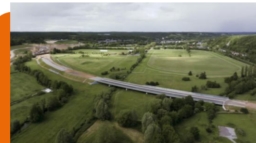
Ouvrage de décharge - Evreux
