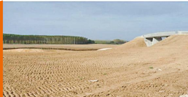
Adoucissement des talus - LGV Rhin-Rhône
