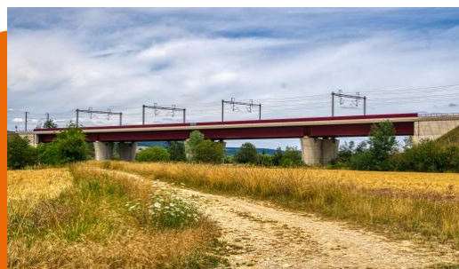
Viaduc de décharge de la Moselle
