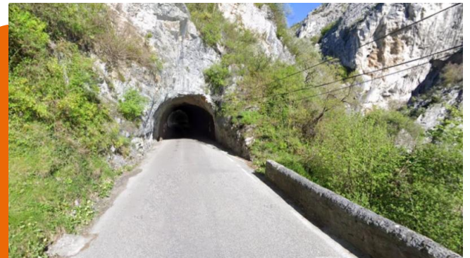
Tunnel des Petits Goulets
