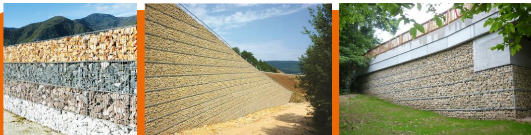
Utilisation des matériaux en gabions
