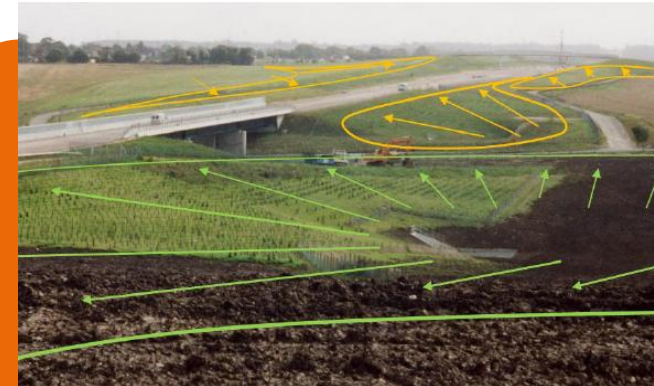
Raccordement au terrain naturel- HS1
