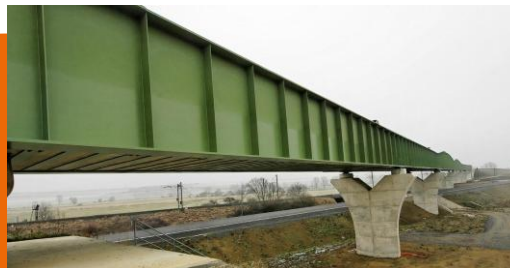
Pont de Baudrecourt - LGV Est
