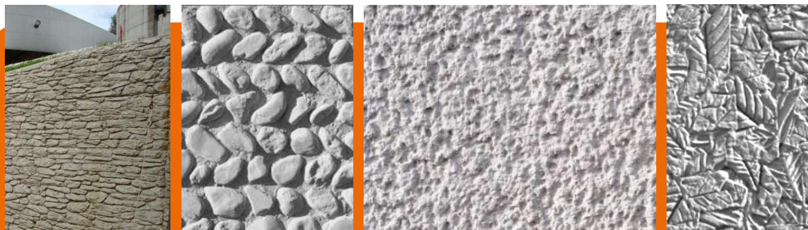
Evocation des matériaux sous forme de béton matricié
