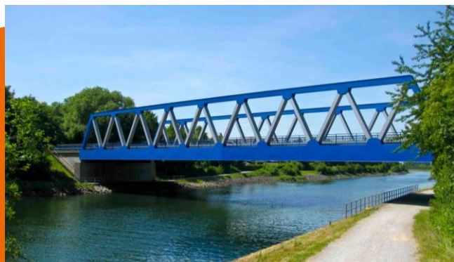
Pont sur le canal Wesel Datteln - Allemagne
