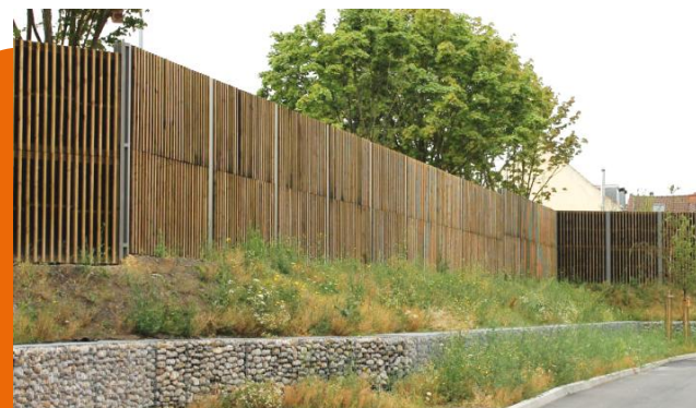
Mur de protection - Décibel France
