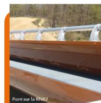
Pont sur la RN82 Corniche
