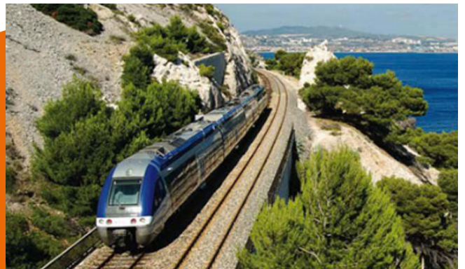
Ligne ferroviaire de la côte bleue - NGE
