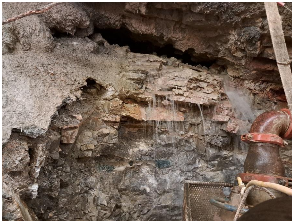
Interception d'un conduit karstique en piédroit, en attente d'aménagement hydraulique (tunnel TELT)
