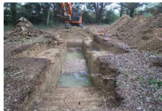
Photo 3 : Exemple de tranchée nécessitant de réaliser des paliers
