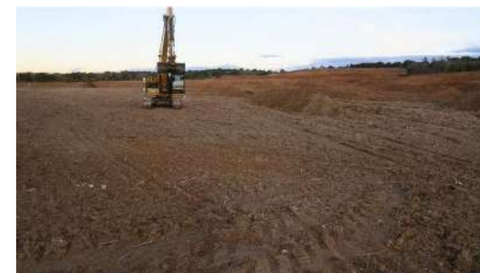
Photo 2 : Exemple de phase d'ouverture des tranchées en cours de réalisation avec une pelle de 20 t
