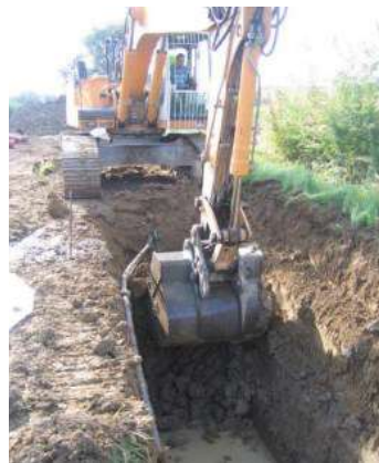
Photo 8 : Réalisation d'un puits à la pelle mécanique
