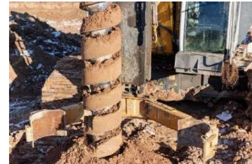
Photo 6 : Extraction d'échantillon remanié à la tarière
