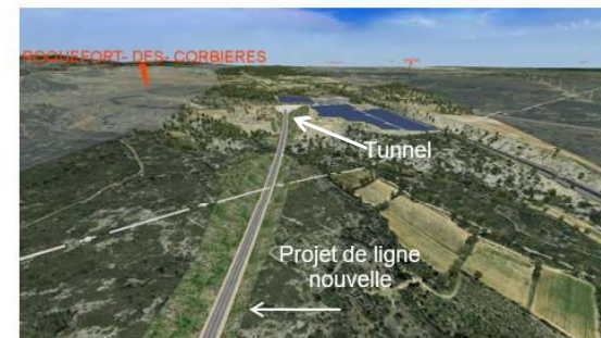
Figure 22 : Franchissement en tunnel au droit de Roquefort-des-Corbières (Source : SNCF Réseau)
