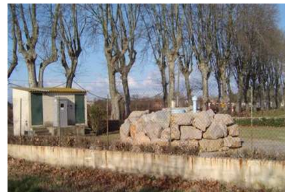
Photo 5 : Périmètre de protection immédiat d'un captage AEP (Source : BRLi 2012)
