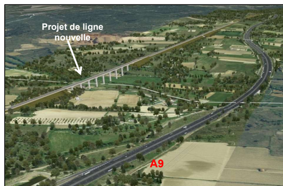
Figure 10 : Franchissement de la vallée du Pallas (Source : SNCF Réseau)
