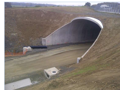
Photo 2 : Tranchée couverte en construction (Source : INGEROP)
