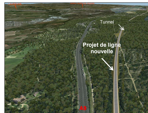
Figure 7 : Secteur de Gigan « Mujan le Vieux » vers le tunnel de la Gardiole (Source : SNCF Réseau)
