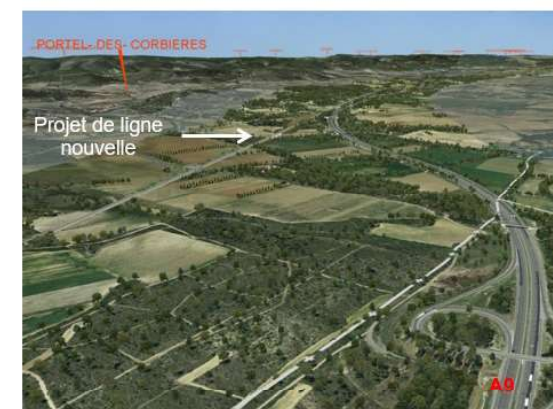
Figure 23 : Franchissement de la Berre (flèche) au-delà de l'échangeur de Sigean (Source : SNCF Réseau)
