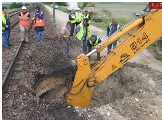
Photo 4 : Effondrement des terrains sous la voie ferrée (Source : Choisy le Roi, Val de Marne (23 janvier 2012))
