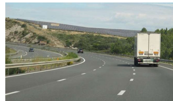
Photo 41 : L'A9 au niveau de Roquefort-des-Corbières (Source : Systra)
