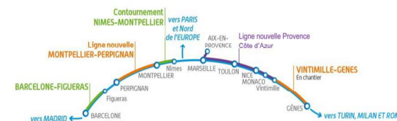
Figure 4 : Un arc méditerranéen en construction (Source : SNCF Réseau)
