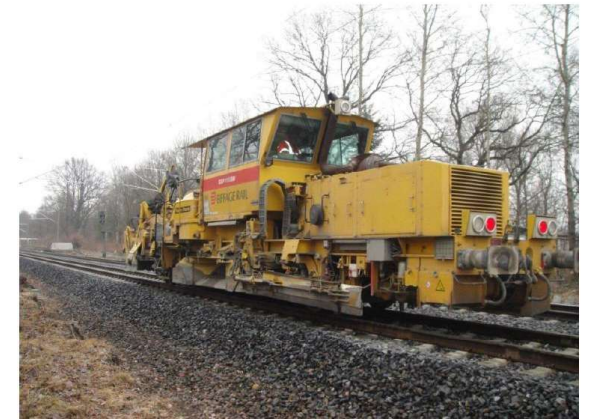
Photo 5 : Travaux de maintenance (Source : SNCF Réseau)
