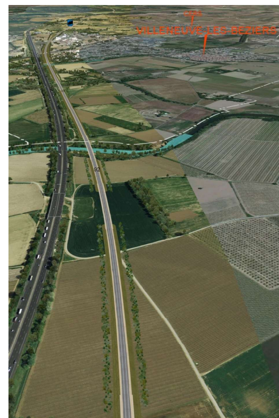
Figure 40 : Franchissement de l'Orb et arrivée sur Villeneuve-lès-Béziers (Source : SNCF Réseau)
