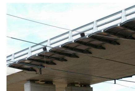
Photo 6 : Auvent de protection caténaire horizontal (Source : SNCF Réseau)
