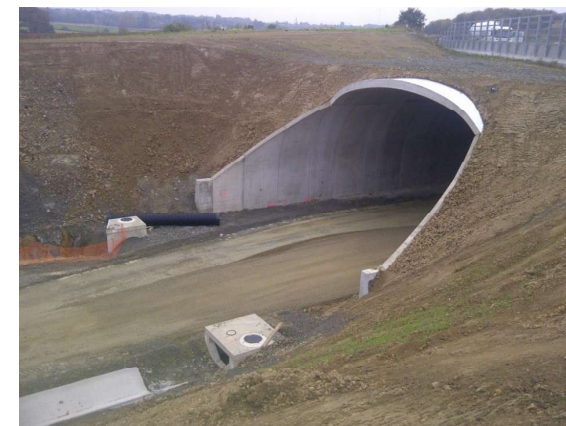
Photo 10 : Tranchée couverte en construction (Source : INGEROP)
