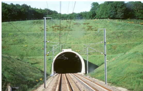
Photo 9 : Tunnel sur LGV Rhin-Rhône (Source : SNCF Réseau)
