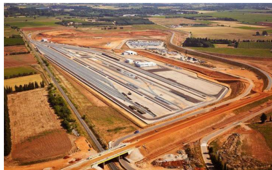
Photo 11 : Double base travaux du Contournement de Nîmes et Montpellier (Source : Oc'Via)
