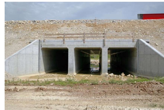
Photo 16 : Dalot Type (Source : SNCF Réseau)
