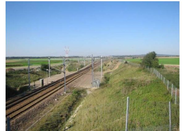
Photo 25 : Clôture et accès à la plateforme (Source : SNCF Réseau)
