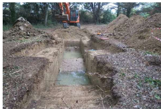
Photo 31 : Exemple de tranchée nécessitant de réaliser des paliers
