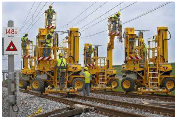
Photo 24 : Pose de caténaire sur LGV (Source : SNCF Réseau)
