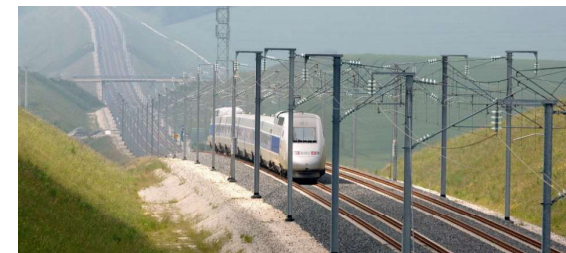
Photo 13 : LGV Est Européenne (Source : SNCF Réseau)
