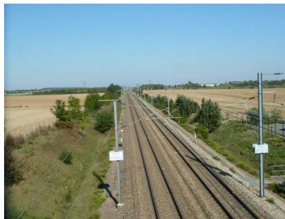
Photo 22 : Caténaires sur LGV à double voie (Source : SNCF Réseau)
