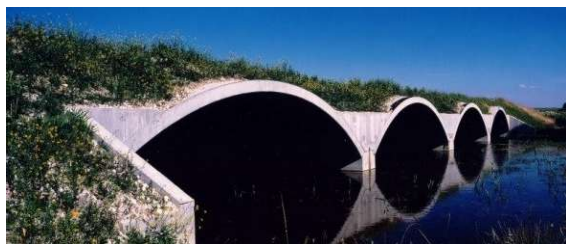
Photo 14 : Photo d'ouvrage multi-voute sous autoroute (Source : INGEROP)
