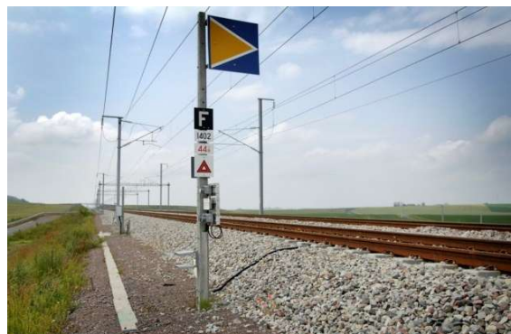
Photo 20 : Repère de signalisation (Source : SNCF Réseau)
