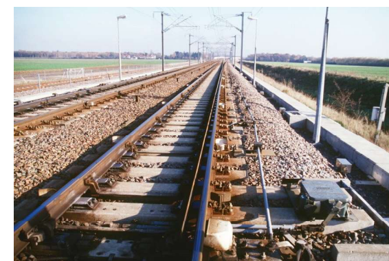
Photo 18 : Appareil de voie franchissable à 230 km/h (Source : SNCF Réseau)
