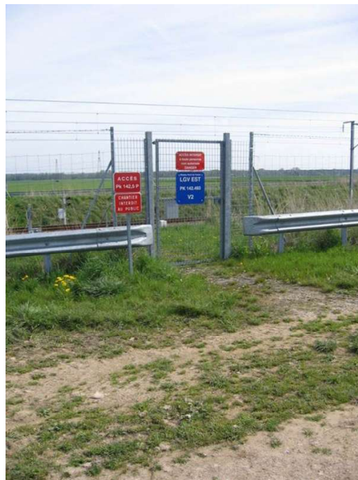
Photo 27 : Portail d'accès piétons (Source : SNCF Réseau)
