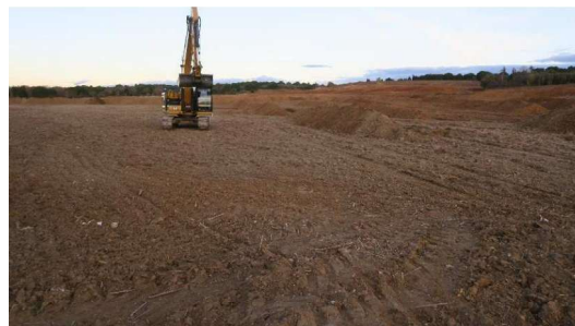
Photo 30 : Exemple de phase d'ouverture des tranchées en cours de réalisation avec une pelle de 20 t
