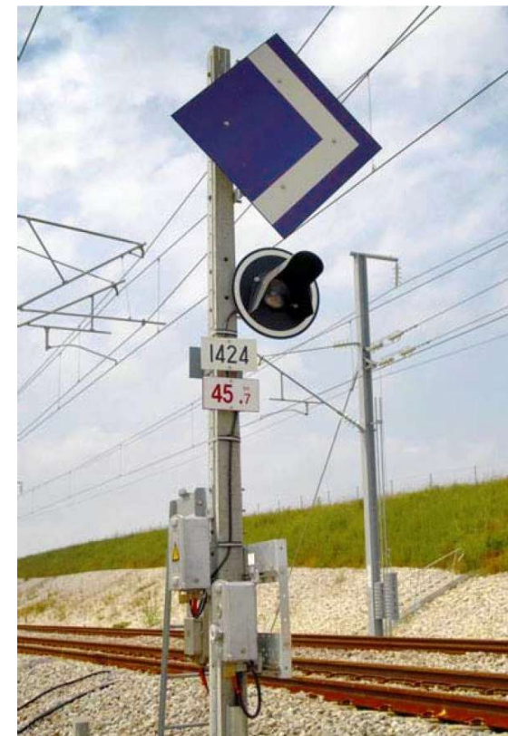
Photo 21 : Jalon de manœuvre (Source : SNCF Réseau)
