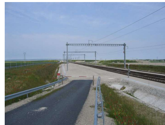
Photo 28 : Aire de montage d'appareils de voie (Source : SNCF Réseau)
