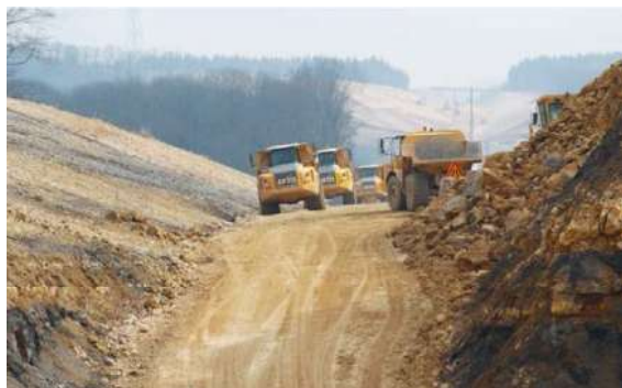
Photo 43 : Travaux de génie civil : terrassements (Source : SNCF Réseau)
