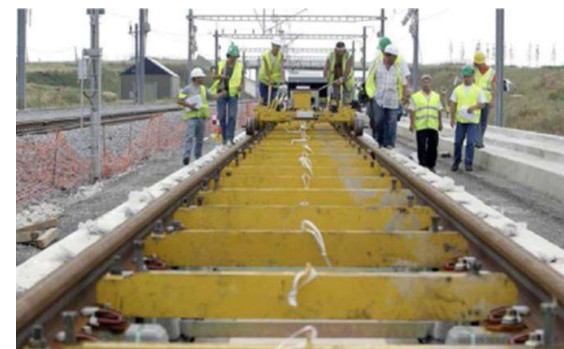
Photo 45 : La mise en place des voies (Source : SNCF Réseau)
