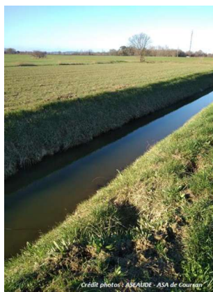
Photo 6 : Canal de l'ASA de Coursan
