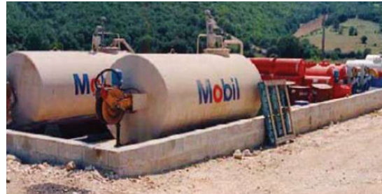
Photo 5 : Exemple de mise en place de bacs étanches pour éviter les fuites accidentelles de carburant (Source : Egis Environnement, SNCF Réseau)
