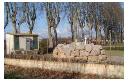
Photo 4 : Périmètre de protection immédiat d'un captage AEP (source : BRLI 2012)
