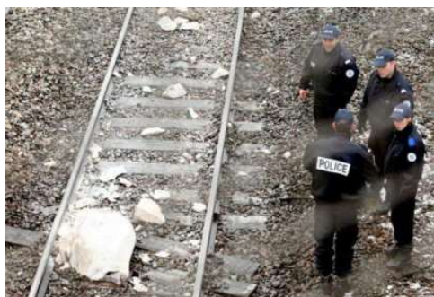
Photo 3 : Chutes de blocs sur la voie ferrée (Source : Choisy le Roi, Val de Marne (23 janvier 2012))
