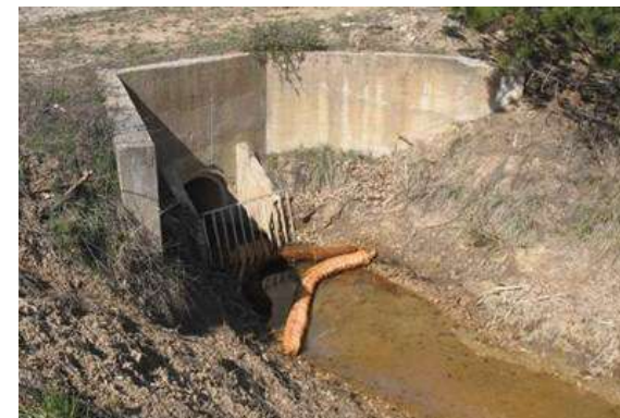
Photo 6 : Exemple d'utilisation d'un boudin dédié à l'absorption des hydrocarbures (Source : ECOMED, 2013)
