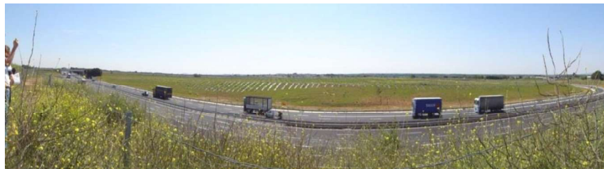
Photo 8 : Echangeur autoroutier A750 / A75, au droit de Béziers (Source : BRLi)
