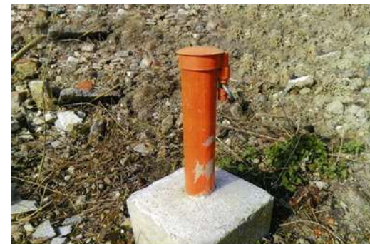
Figure 11 : Vue d'une tête de piézomètre cadenassée avec massif scellé
