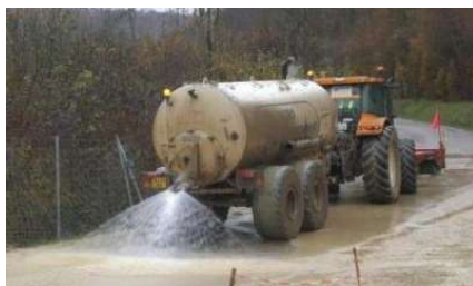
Photo 5 : Exemple d'arroseur sur piste de chantier (Source : http://www.lgvrhinrhone.com )
