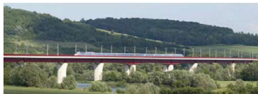
Figure 20 : Viaduc, enjambant le lit mineur (Source : Egis)
