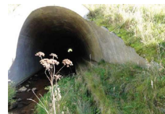
Figure 19 : Ouvrage aménagé sur un côté pour le passage de la faune semi-aquatique
