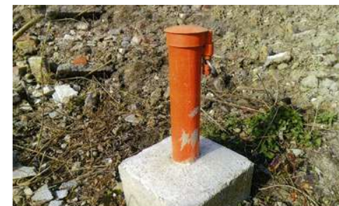
Figure 25 : Vue d'une tête de piézomètre cadenassée avec massif scellé
