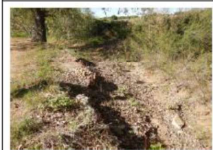
Protection de berges
