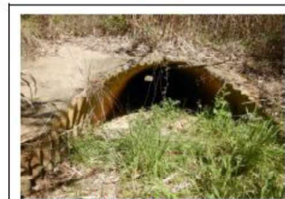
Buse du pont de l'A9
