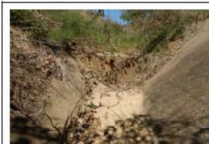
Seuil en amont de l'A9
