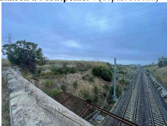
Remblai sur lequel la LNMP se poursuivra au-dessus de la voie existante. Sondages et mesures d'évitement prévus sur site
