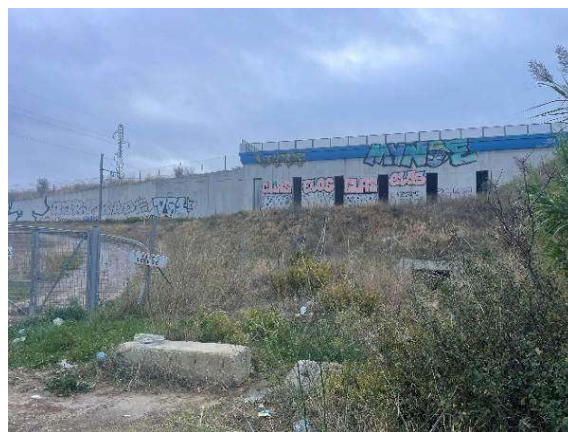
Le raccordement se fera dans le prolongement de la gare Sud de France et ouvrage de génie civil déjà en place.
