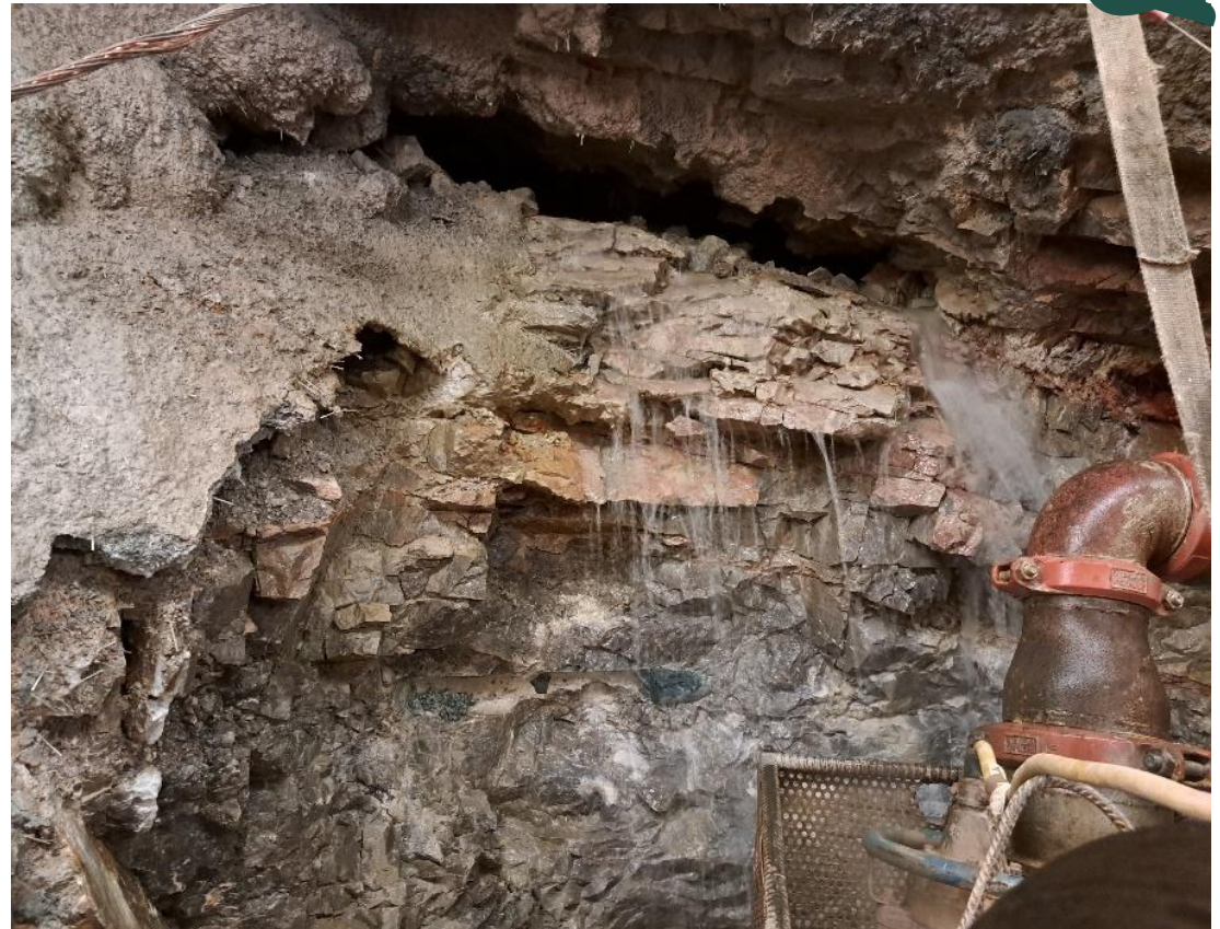
Interception d'un conduit karstique en piédroit, en attente d'aménagement hydraulique (tunnel TELT)
