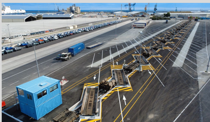
Plateforme ferroviaire du Port de Sète avec technologie de chargement horizontal
