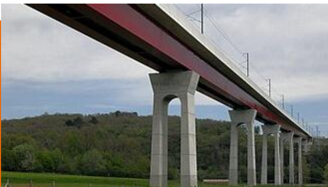
Pont de la Lizaine - LGV Est
