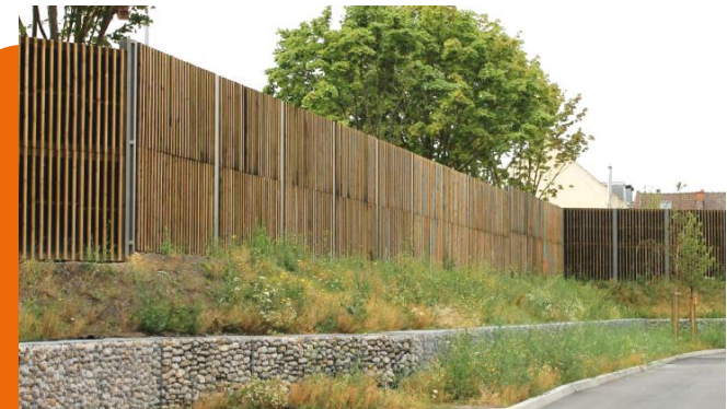
Mur de protection - Décibel France
