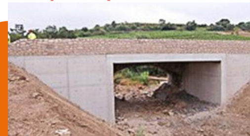
Passage faune sur l'A9
