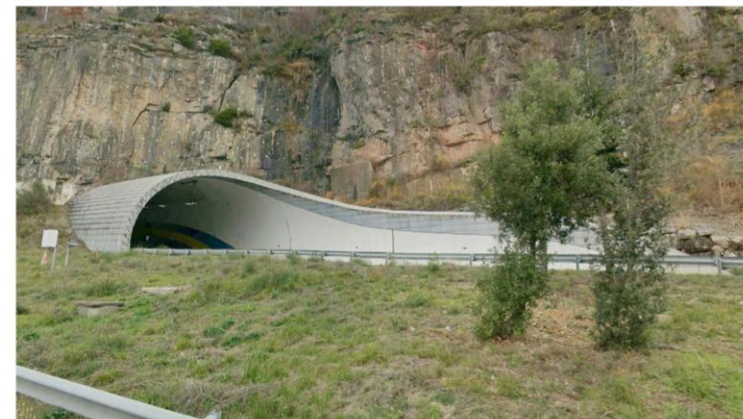
Tunnel du Pas de l'Escalette A75
