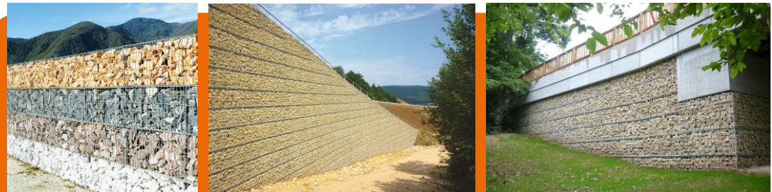
Utilisation des matériaux en gabions
