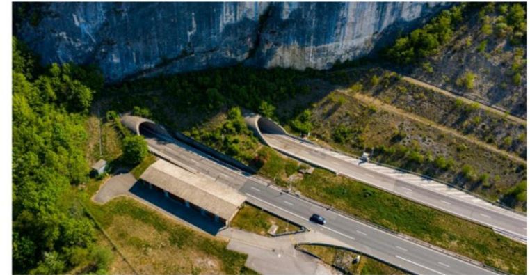
Tunnel du Vuache A40
