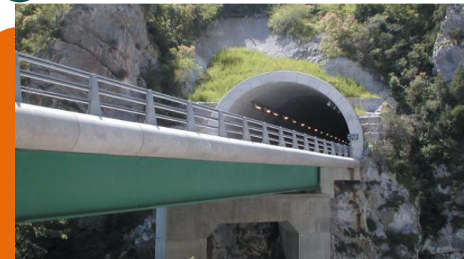
Tunnel de Saorge - RD38
