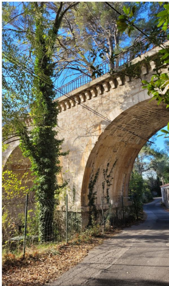
Ancienne ligne ferroviaire de Montbazin-Gigean à Sète-Ville
