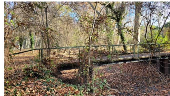
Serrurerie et fer forgé des garde corps du Parc d'Issanka
