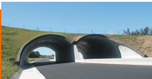
Passage faune sur l'A9
