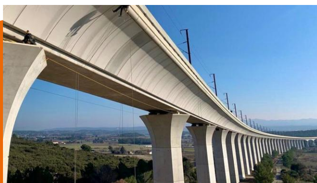
Pont de Ventabren - LGV Méditerranée
