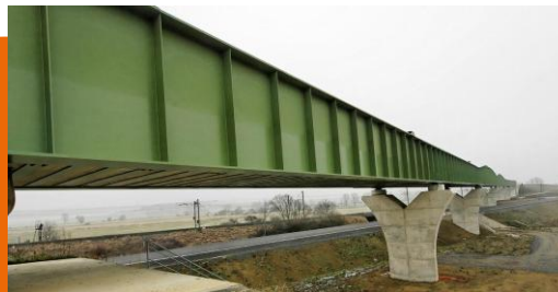
Pont de Baudrecourt - LGV Est
