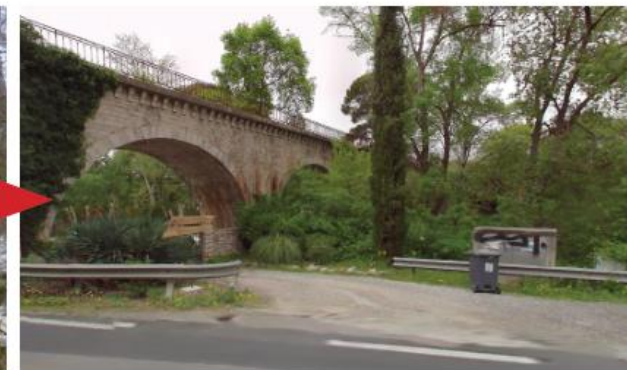
2024 - route départementale D2 Source : Google Maps
