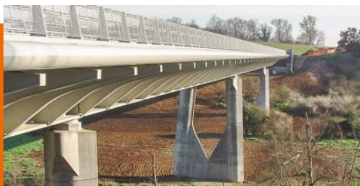
Pont sur la Sevre Nantaise
