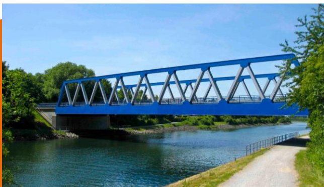
Pont sur le canal Wesel Datteln - Allemagne
