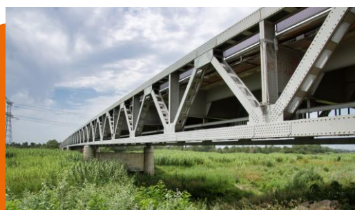
Ouvrage de décharge - Cavillon
