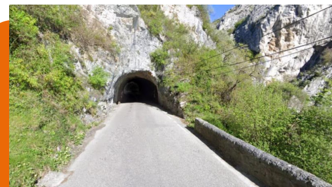
Tunnel des Petits Goulets
