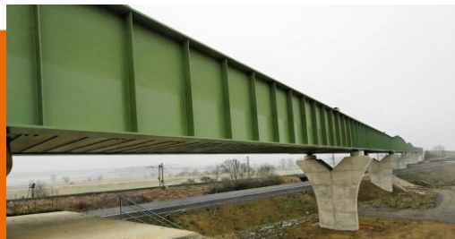
Pont de Baudrecourt - LGV Est
