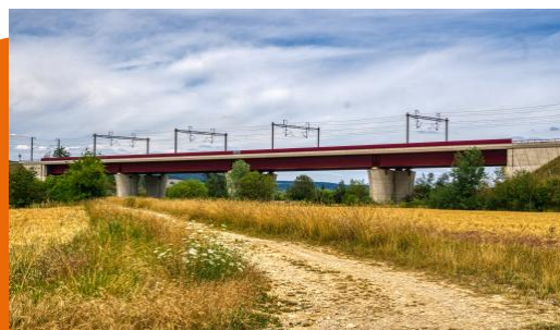
Viaduc de décharge de la Moselle
