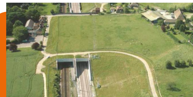
Tranchée couverte sur HS1
