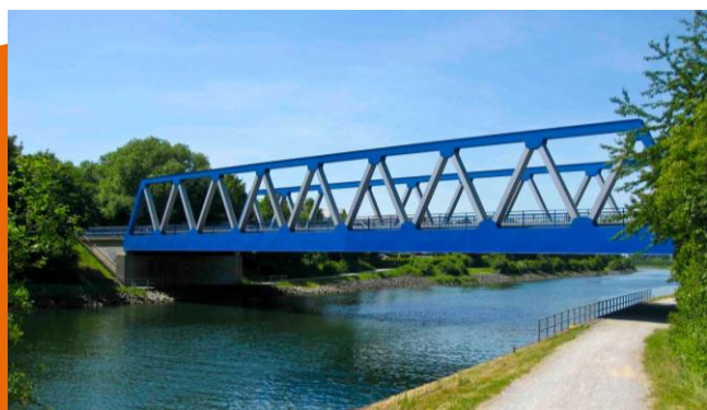
Pont sur le canal Wesel Datteln - Allemagne
