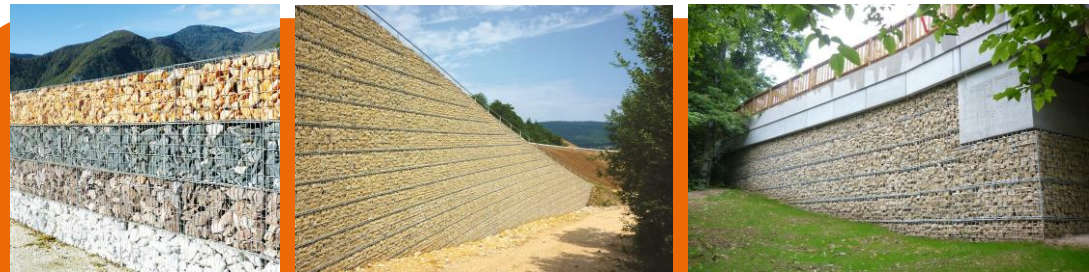
Utilisation des matériaux en gabions
