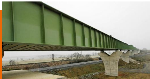
Pont de Baudrecourt - LGV Est
