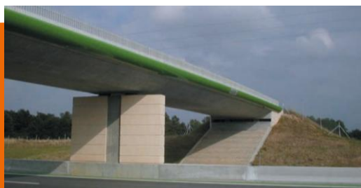
Ouvrage sur l'A89
