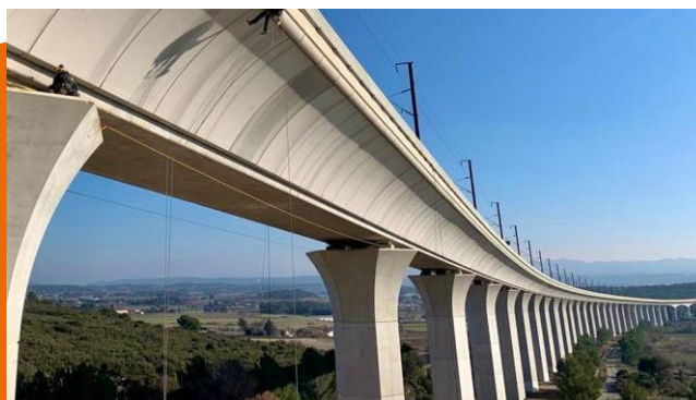
Pont de Ventabren - LGV Méditerranée
