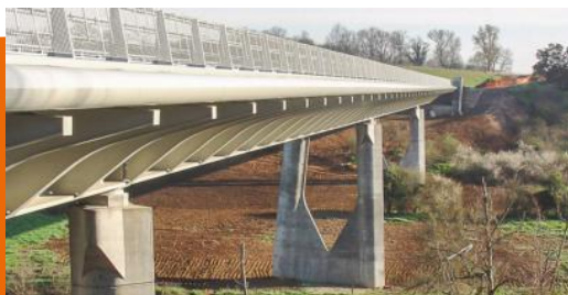
Pont sur la Sevre Nantaise
