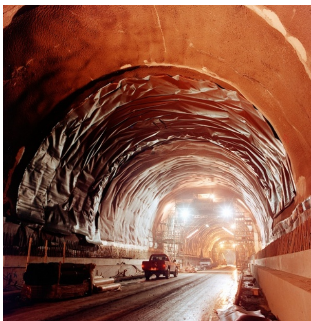
Tunnel ferroviaire en construction (source Duchène SA)
