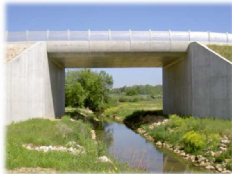
Photographie 40 : Ouvrage de type « portique » préservant berges et lit mineur (LGV Rhin-Rhône) (source : SNCF Réseau)
