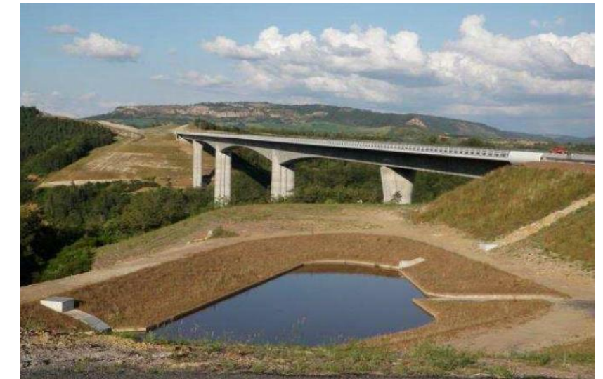
Photographie 3 : Exemple de bassin de compensation à l'imperméabilisation (BRS)
