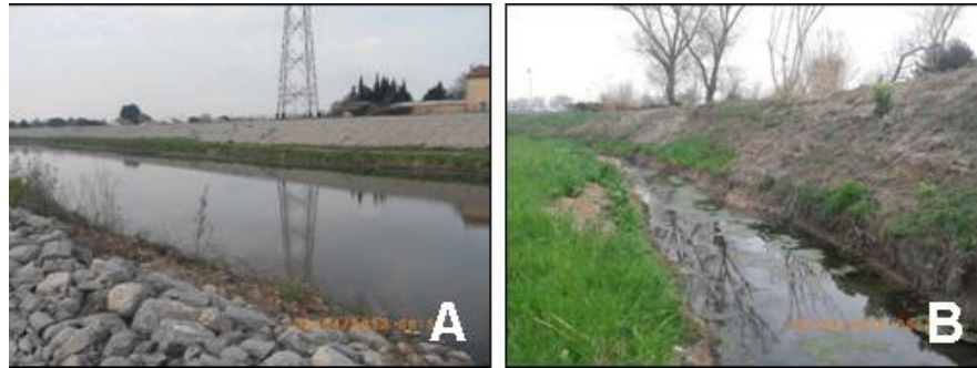
Photographie 8 : Exemples de digues (source : ASCONIT Consultants)
