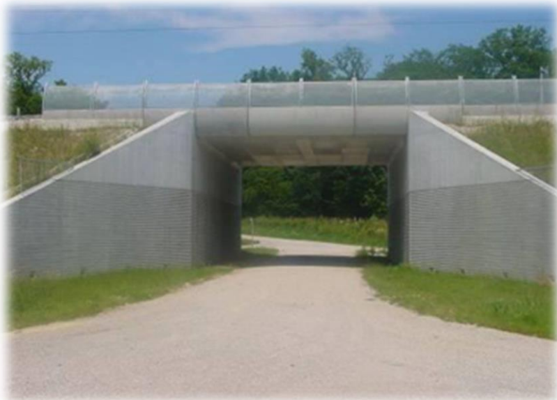
Photographie 42 : Pont cadre à usage mixte – Faune / Voies d'accès (sources : ECOMED (haut), SNCF Réseau (bas))
