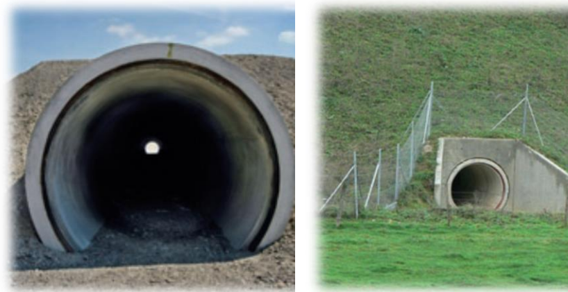
Photographie 36 : Passage à faune supérieur (LGV Est européenne) (source : SNCF Réseau)
