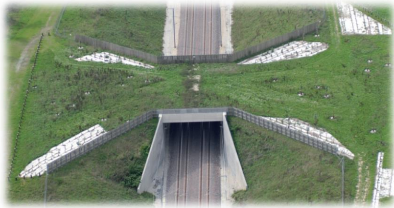
Photographie 35 : Passage à faune supérieur (LGV Est européenne) (source : SNCF Réseau)
