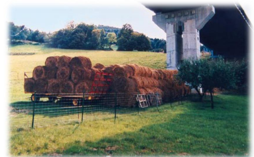
Photographie 37 : Viaduc (source : Jean Carsignol, 09/05/2011)
