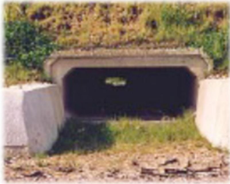
Photographie 39 : Exemple de dalots adaptés au passage des amphibiens (source : Jean Carsignol, 09/05/2011)
