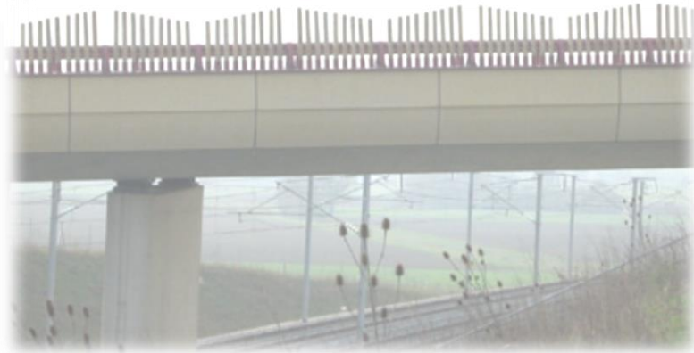
Photographie 38 : Aménagements pour les chiroptères (LGV Est européenne) (source : SNCF Réseau)
