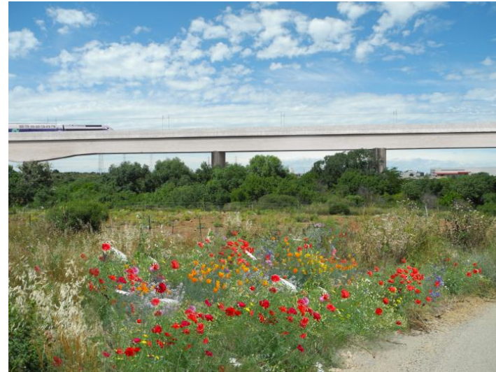
Photo 10 : La ripisylve de la Mosson préservée par la mise en œuvre d'un viaduc (exception faite au droit des piles soutenant l'ouvrage) (source : Ingérop, 2016)
