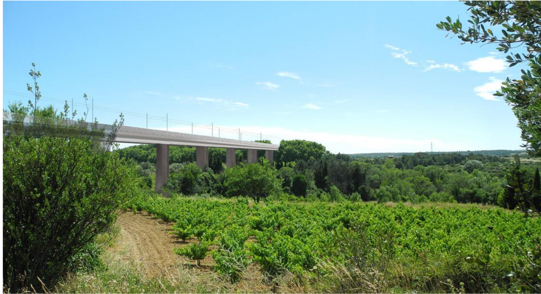
Figure 64 : le viaduc de la Vène (bipoutre), photo réaliste depuis chemin de Lisée – vue prévisionnelle indicative (source : Ingerop)
