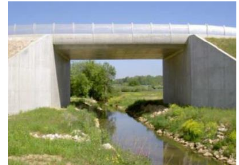
Photo 5 : Exemple d'ouvrage d'art courant de type portique
