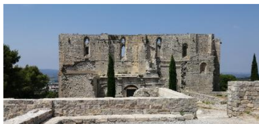
Photo 32 : Abbaye de Saint-Félix de Monceau (SNCF Réseau, 2021)
