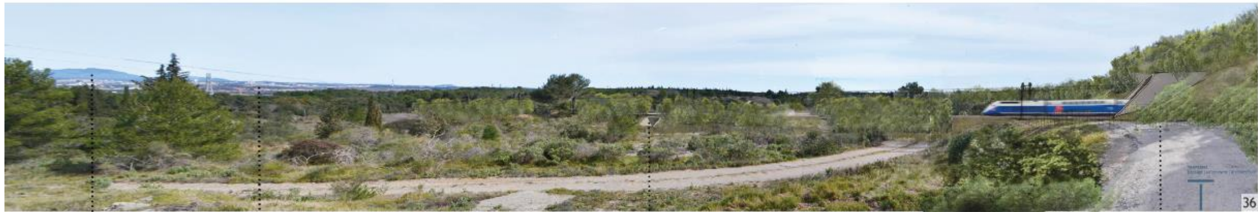
Figure 46 : photomontage de tête de tunnel de la Gardiole, photo réaliste depuis le chemin de Saint-Bauzille – Vue prévisionnelle indicative (source : Traverses)
