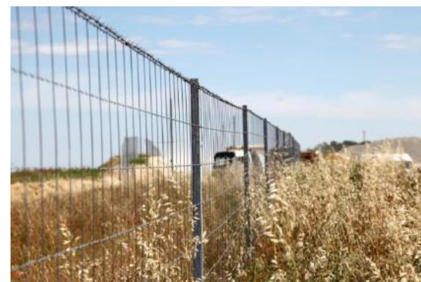
Photo 8 : Exemple de clôtures définitives sur le chantier de la LGV SEA (source : © Marc Montméat pour LISEA)
