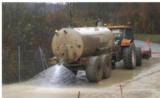
Photo 24 : Exemple d'arroseur sur piste de chantier (source : http://www.lgvrhinrhone.com )
