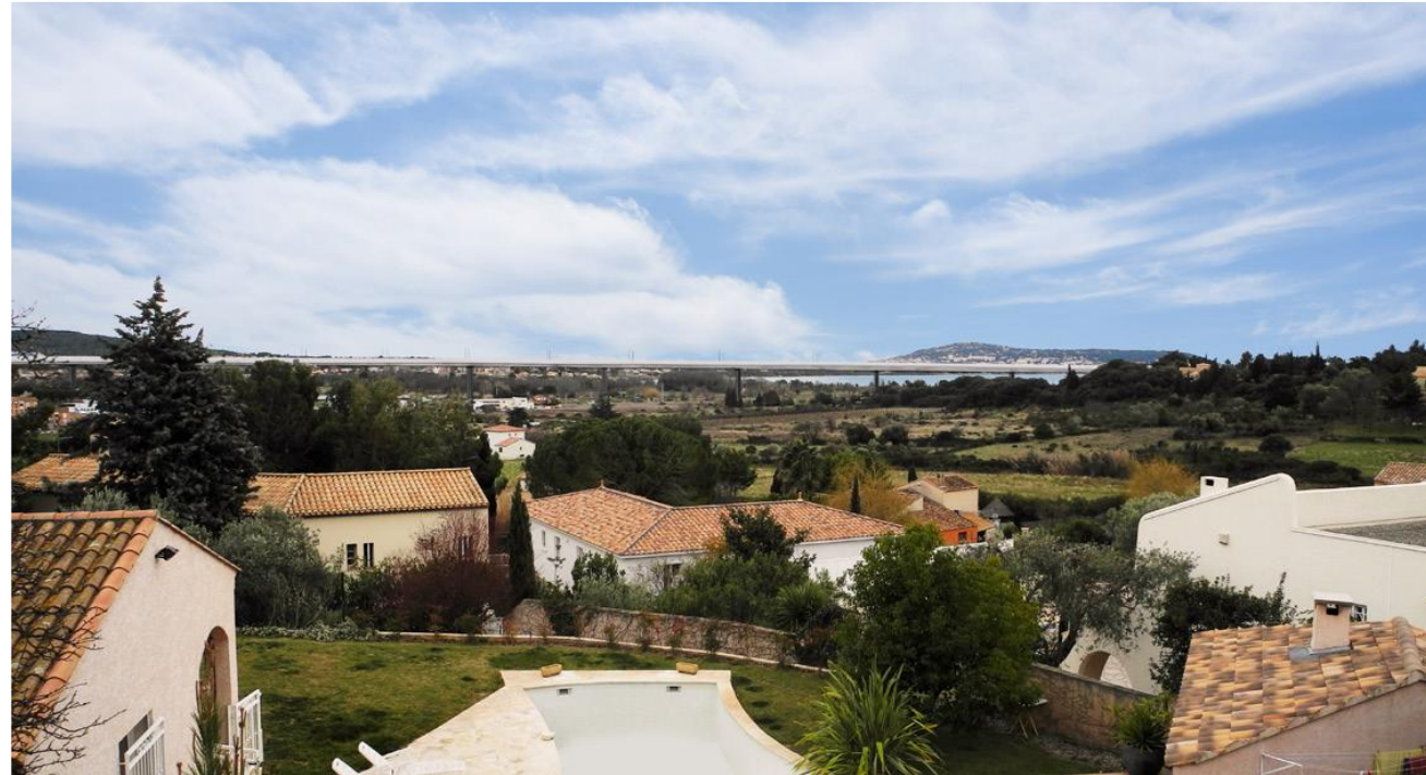
Figure 62 : le viaduc de Poussan depuis le lotissement Le Giradou – vue prévisionnelle indicative (source : Ingerop)
