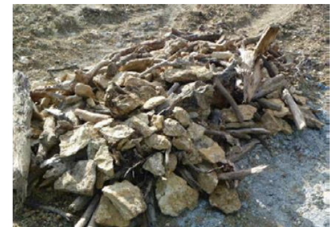
Figure 20 : Hibernaculum en cours de construction (source : Ecosphère)
