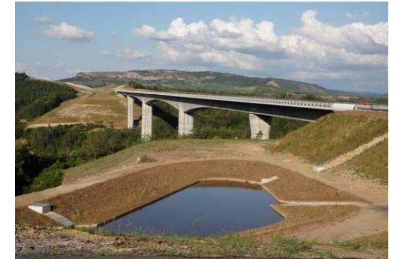
Photo 7 : Exemple de bassin de compensation à l'imperméabilisation
