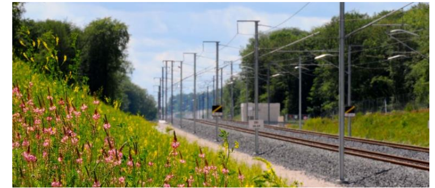
Photo 20 : Végétalisation des talus de la Ligne LGV Rhin-Rhône, nouveau support de biodiversité ordinaire (source : Favoriser et préserver la biodiversité, LGV Rhin-Rhône Branche est, SNCF Réseau)
