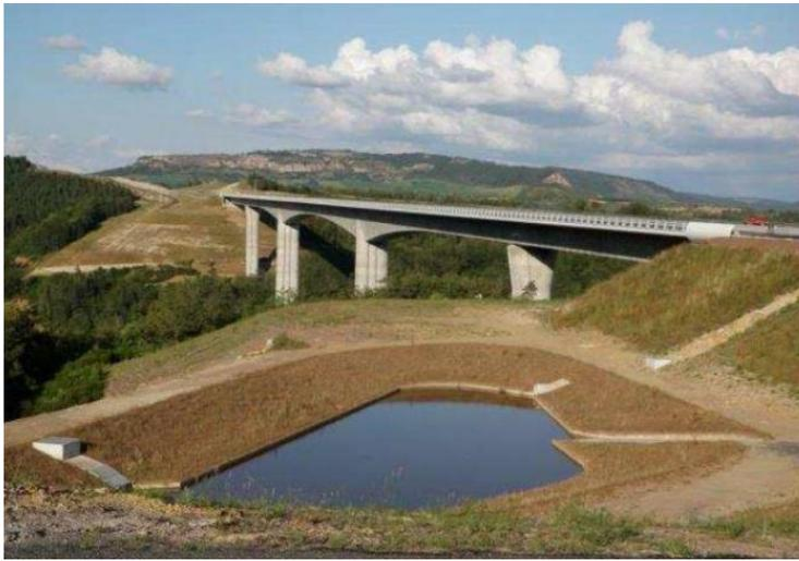
**Photo 14 : Exemple de bassin de compensation à l'imperméabilisation**
