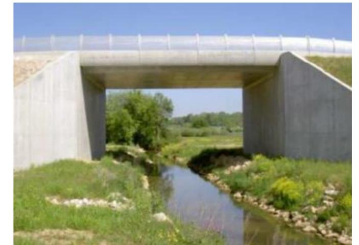
Photo 10 : Exemple d'ouvrage d'art courant de type portique (source : ONEMA)
