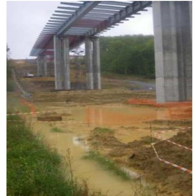
**Photo 13 : Ruissellement et départ massif de matière en suspension sur terre décapée (source : ONEMA)**
