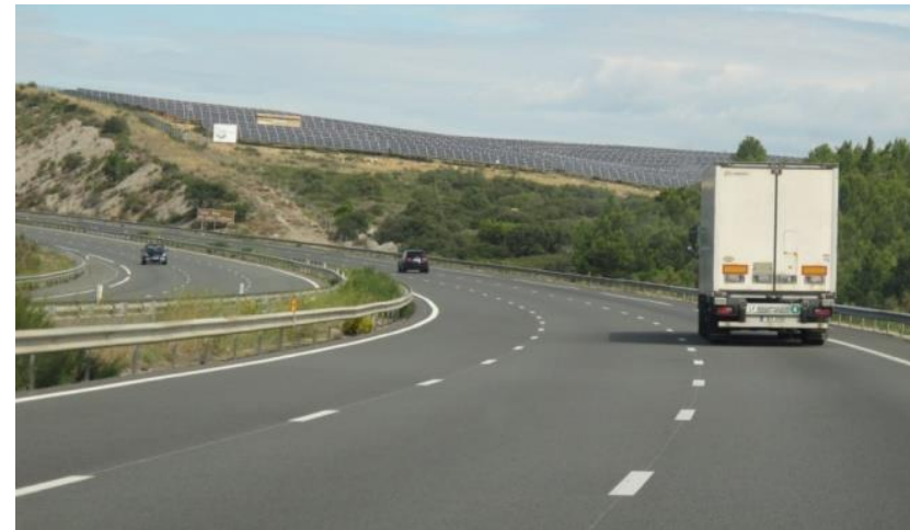
Photo 40 : L'A9 au niveau de Roquefort-des-Corbières (source : Systra)
