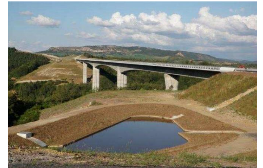
Photo 7 : Exemple de bassin de compensation à l'imperméabilisation
