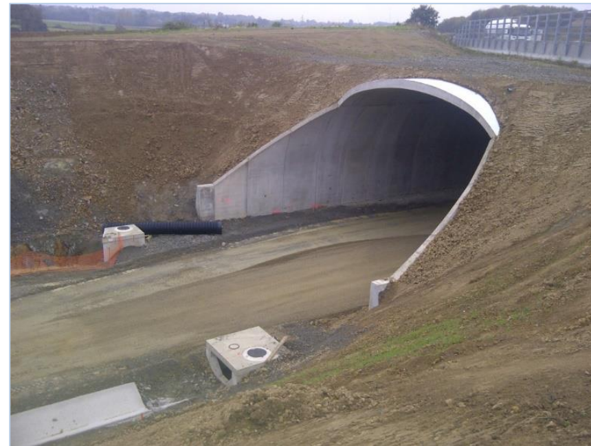
Photo 2 : Tranchée couverte en construction (source : INGEROP)
