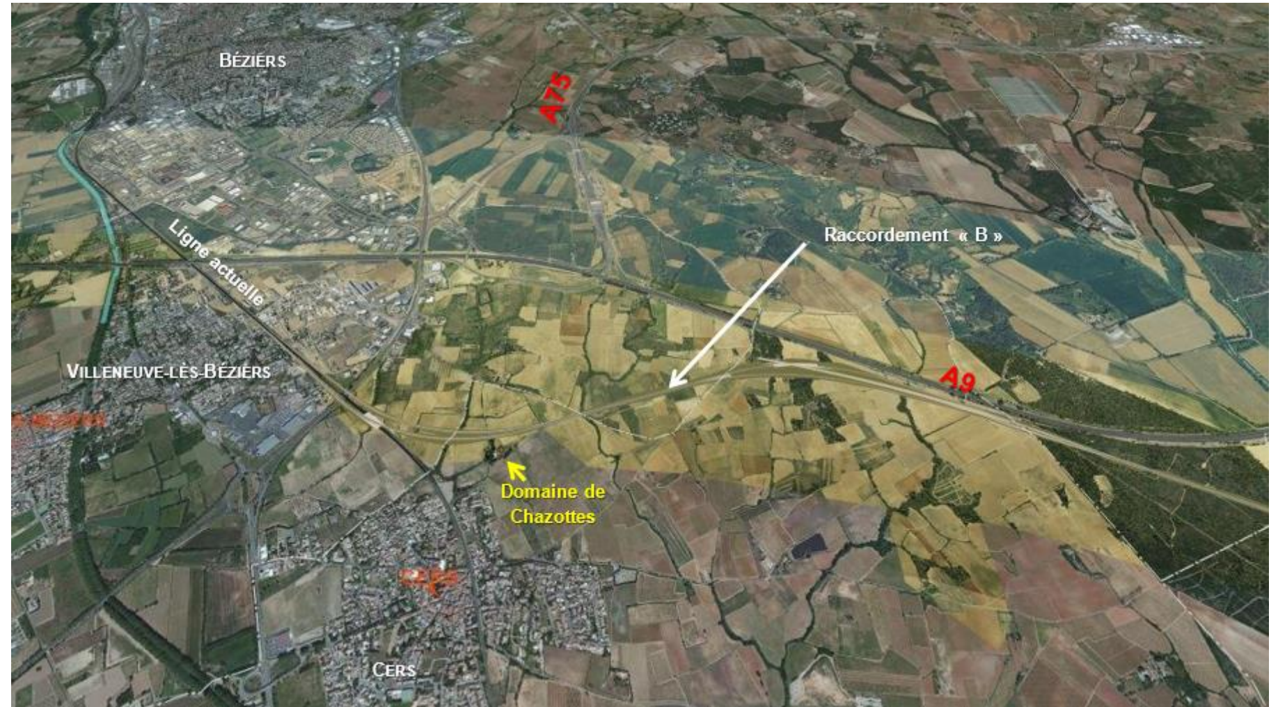
Figure 6 : Amorce de la LNMP à l'est de Béziers – Raccordement « B » (source : SNCF Réseau)
