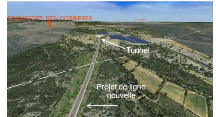
Figure 21 : Franchissement en tunnel au droit de Roquefort-des-Corbières (source : SNCF Réseau)
