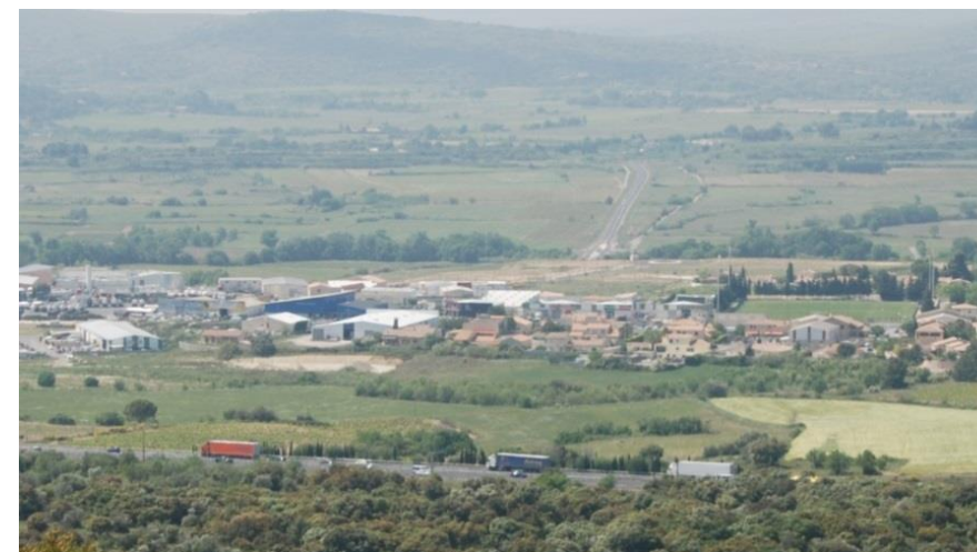
Photo 34 : Commune de Gigan (source : Systra)
