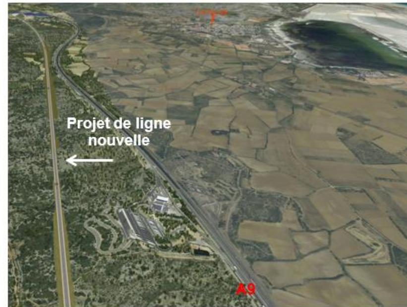
Figure 20 : LNMP au niveau de l'aire de repos de la Palme, en haut à droite l'étang et la commune de la Palme (source : SNCF Réseau)
