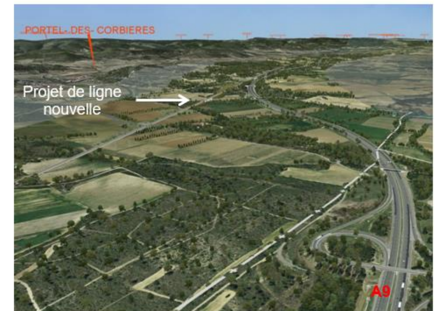
Figure 22 : Franchissement de la Berre (flèche) au-delà de l'échangeur de Sigean (source : SNCF Réseau)
