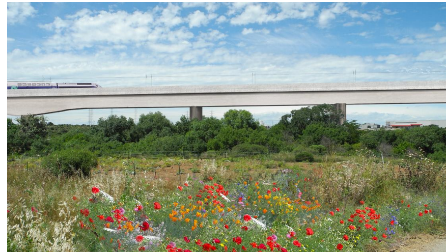
Figure 54 : Le viaduc de la Mosson, photo réaliste depuis la Route de Sète (caisson à hauteur variable) – vue prévisionnelle indicative (source : Ingerop)
